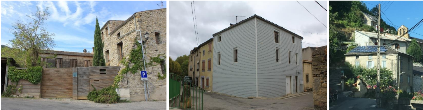
A gauche et au centre, deux exemples de réhabilitation : à Cailla, bonne intégration du bois par son aspect et sa couleur ; à Chalabre, le matériau s'intègre moins bien dans son environnement (couleur, type d'enduits, pierres, etc.) / Intégration des panneaux solaires sur toiture à Merial
