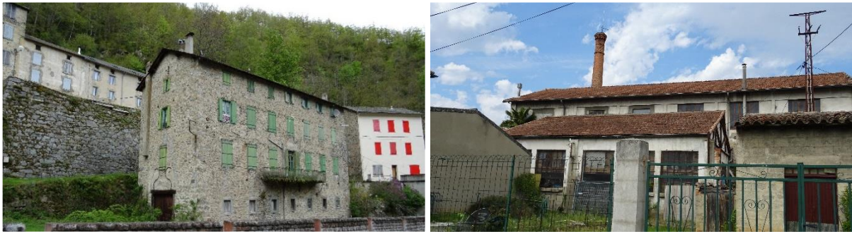
Bâtiments inoccupés à Escouloubre les Bains ; Anciens bâtiments d'activité à Esperaza.
