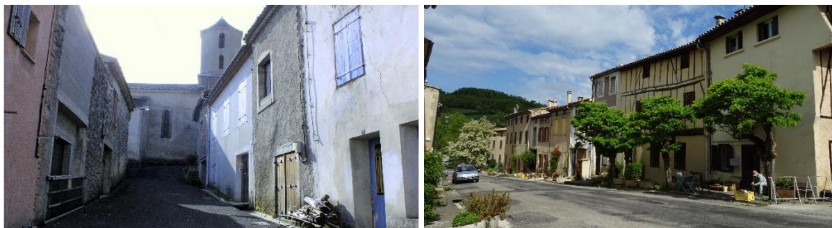
Paysage de « volets clos » au cœur de Coudons ; bâtiments réhabilités au centre de Rivel.
