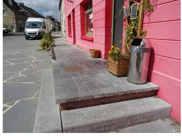
Abords du café à Eppe-Sauvage, l'emmarchement d'un côté et la rampe de l'autre ne forme qu'un seul élément de transition réalisé avec soin.
