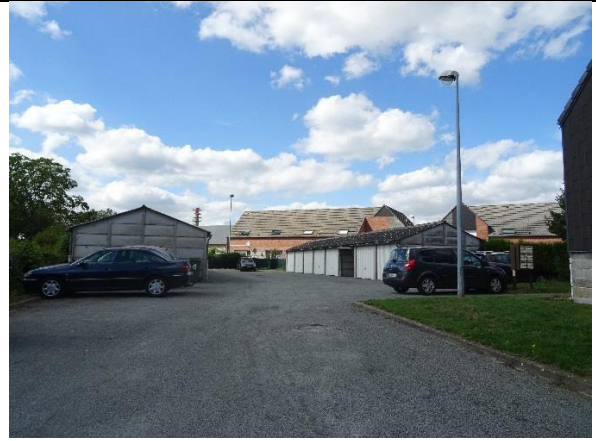
Garages et places de stationnement regroupées au cœur de l'opération le Clos des Horbes à Ohain, non visibles depuis les rues principales.
