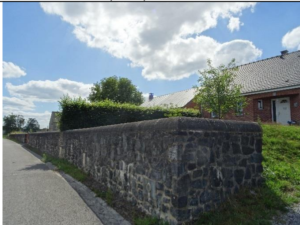
Exemple de mur de soutènement en pierre bleue en limite de parcelle à Wallers-en-Fagne conservé lors de la construction d'une maison individuelle.
