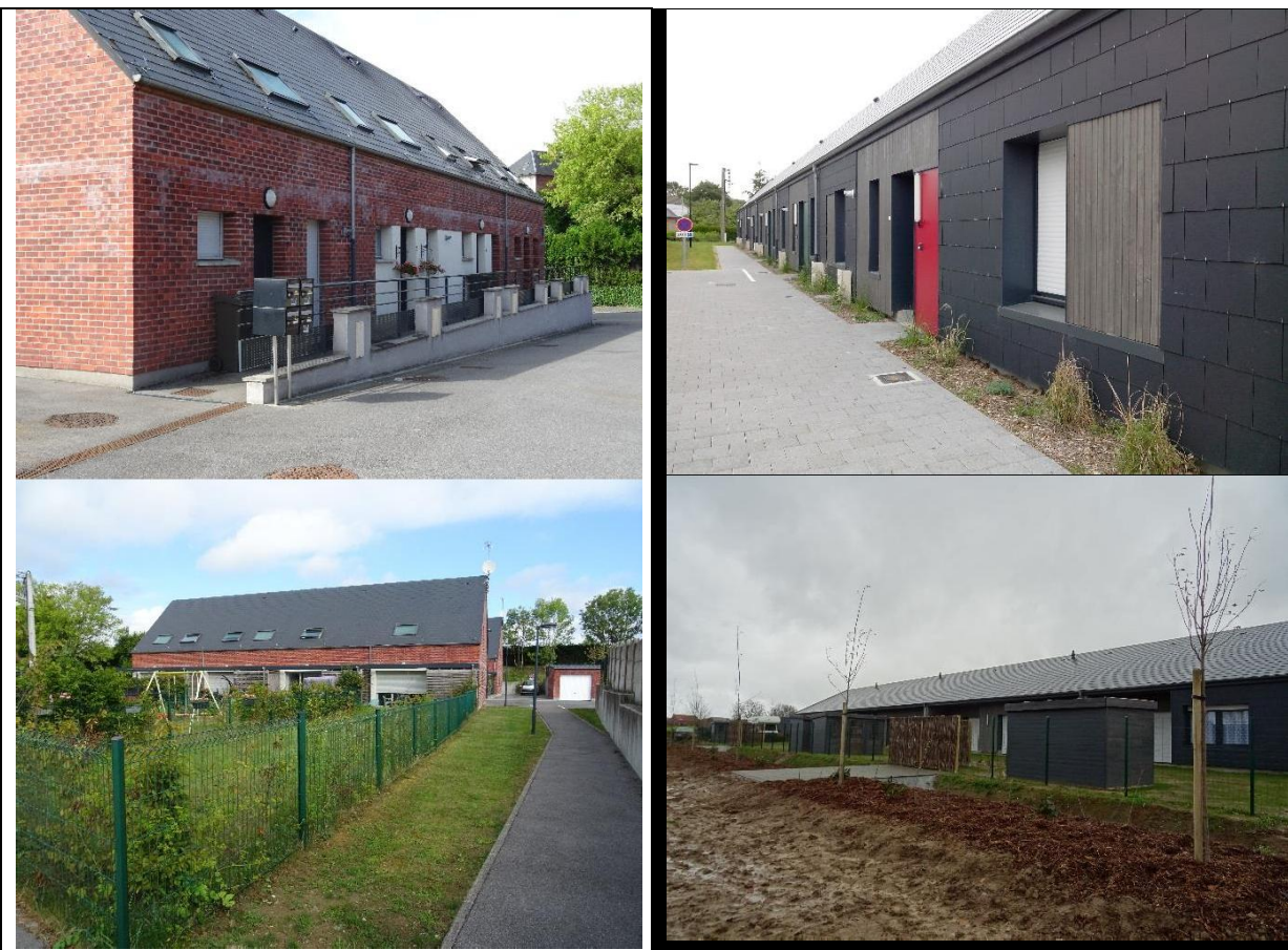
A Wignehies (opération rue du Dr Brunel) et à Ors (éco-quartier), l'implantation des constructions permet une exploitation optimum des énergies naturelles notamment l'ensoleillement des pièces à vivre orientées au sud, et les façades plus fermées accueillant les entrées et pièces secondaires au Nord.
