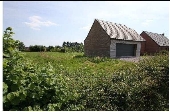
A Clairfayts (3CA), la nouvelle construction n'occupe pas toute la largeur de la parcelle, l'implantation sur une limite séparative permet de respecter la structure urbaine de la rue tout en favorisant des vues vers le paysage à l'arrière du terrain.
