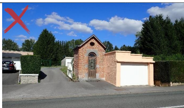
Cette chapelle à Ohain est en bon état de conservation, toutefois la présence d'un garage accolé d'un côté, l'accès à des parkings de l'autre et le macadam qui arrive au ras de l'édifice nuisent à sa valorisation.
