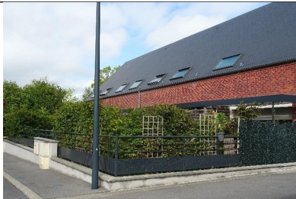
Cette opération à Wignehies propose des matériaux en adéquation avec les caractères constructifs de la commune : ardoise synthétique avec un petit module, brique rouge-orangée, béton pour former un socle, clôture métallique ajourée doublée d'une haie.
