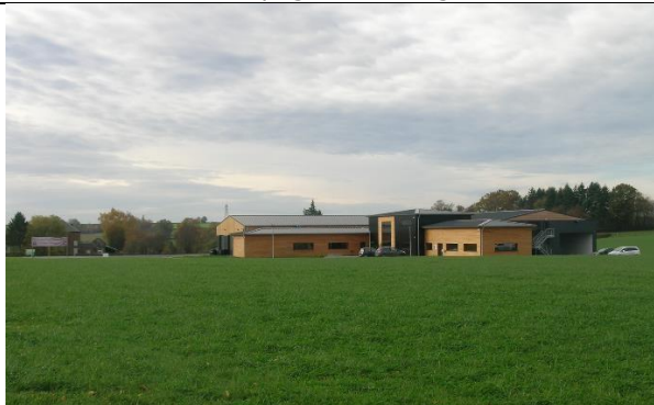
Exemple de bâtiment d'activité réinterprétant la forme de la ferme L avec des teintes neutres (Ferme du Pont des Loups – 3CA)
