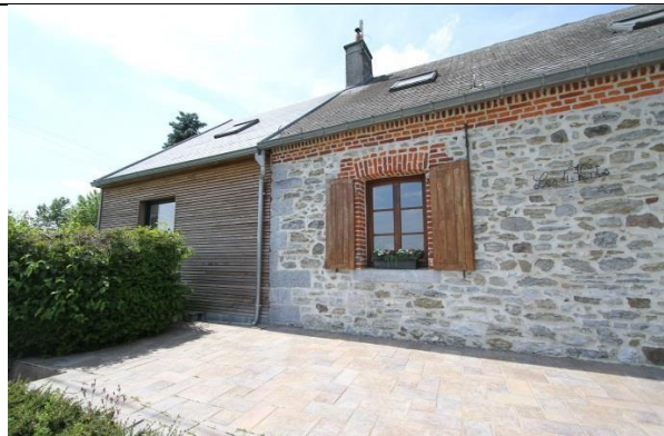
Extension en bois d'une maison élémentaire à Epe-Sauvage qui prolonge le volume existant. L'aspect contemporain est affirmé tout en mettant en valeur le patrimoine bâti ancien.
