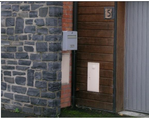
Coffrets et boîte aux lettres regroupés et intégrés dans la façade d'une construction (Féron)
