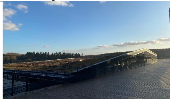
Toiture végétalisée de la piscine du Val Joly qui semble se fondre dans les horizons boisés en arrière-plan.
