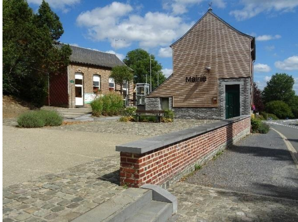
Aménagement des abords de la mairie de Willies : muret, pente, emmarchement traduisent l'adaptation des espaces public au relief.
