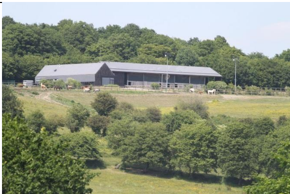
Centre équestre du Val Joly : la composition d'ensemble, marquée par la simplicité des volumes, fait écho à l'architecture rurale du territoire. Les lignes horizontales et les couleurs sombres se fondent dans la lisière.
