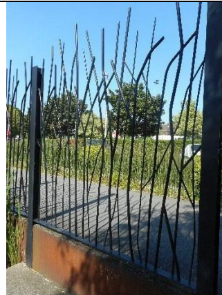
Clôture en fer forgé laissant apparaître un jardin public (Jardin des Géants - Lille).
