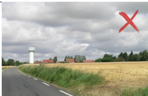
Extension linéaire en haut de versant et sur le plateau qui rompt avec l'implantation traditionnelle du village parallèlement au cours d'eau à mi-versant (CCPM).
