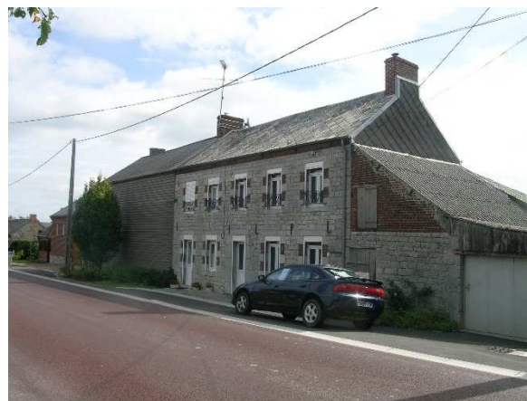
Extension en bois réalisée dans le respect du gabarit existant, Hestrud. Source : PNR de l'Avesnois
