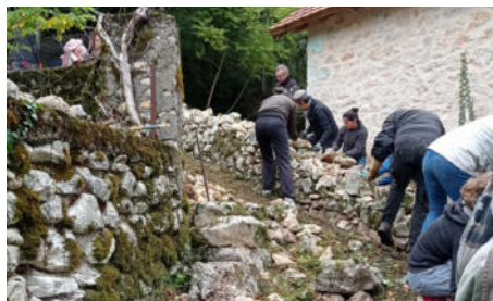
Chantier de restauration d'un muret en pierre sèche dans le cadre du programme de réhabilitation des murets instauré par le Parc Naturel Régional des Causses du Quercy Crédits : MAA
