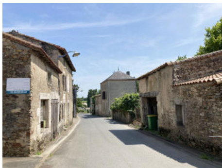
Vacance et abandon : un nombre important de constructions sont en sursis le long des voies principales
