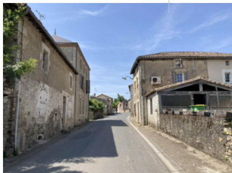
Rue de la Miochette, le trafic de la route départementale influe sur le bâti : fragilisation structurelle, accidents, gestion des eaux
