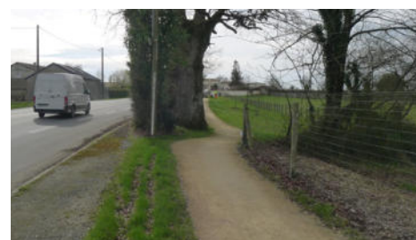
Aménagement de piste cycles & piétons entre Pompaire et Parthenay. Cette piste fortement empruntée s'écarte de la route lorsque cela est possible et s'appuyant favorablement sur le maillage bocager existant pour révéler des vues sur les prés.
