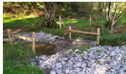
Création d'un ouvrage de franchissement agricole associé aux travaux de renaturation du cours d'eau
