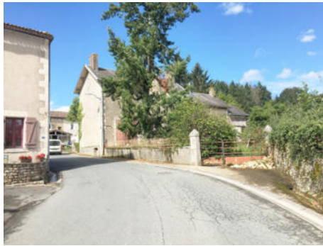
Pente importante dans la rue du Val de Miochette. Le projet tendrait à dévier les eaux de ruissellement de voirie vers la parcelle en prairie sur la droite de l'image
