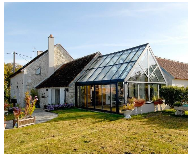
Extension présentant des qualités énergétiques
