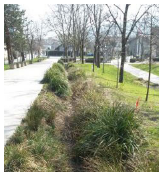
Noue d'infiltration ©SYMASOL, 2016
