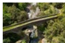
P69 Pont de Rejus Pont-de-Labeaume
