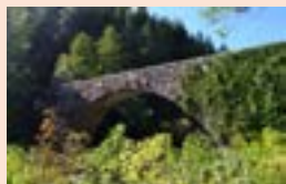
P1 Pont du Sigadou Barnas
