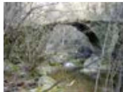
P48 Pont-Rieuclard Jaujac
