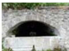
P17 Source voûtée Burzet
