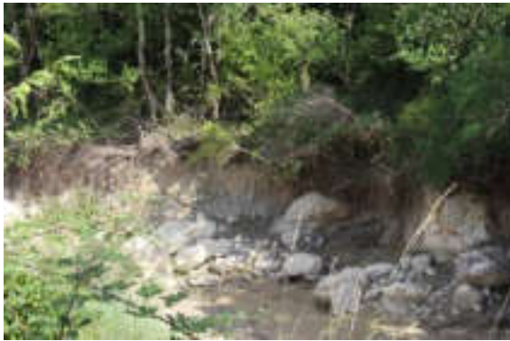
Lit mineur du ruisseau en aval de LAN02
