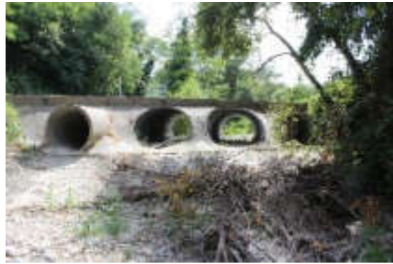
Aval de l'ouvrage LAN01
