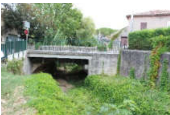
Aval du ruisseau du Saint-Julien - Ouvrage STJ04
