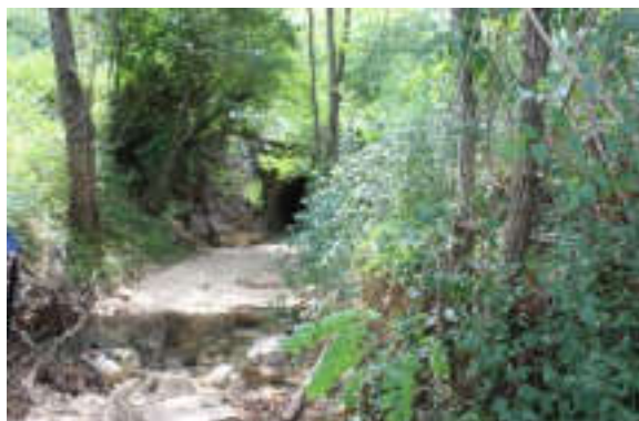
Aval de l'ouvrage LAR01
