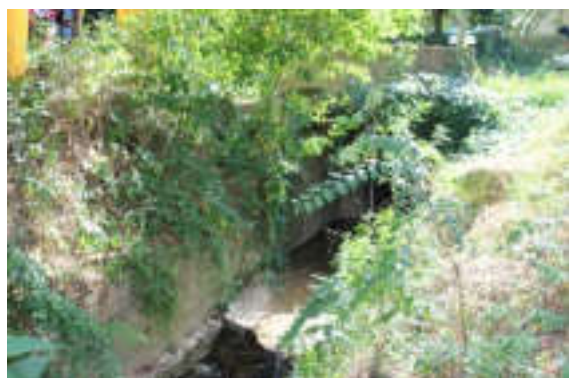
Aval du ruisseau du Saint-Julien - Ouvrage STJ01
