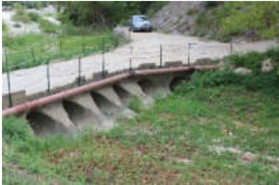
Amont de l'ouvrage RIE01
