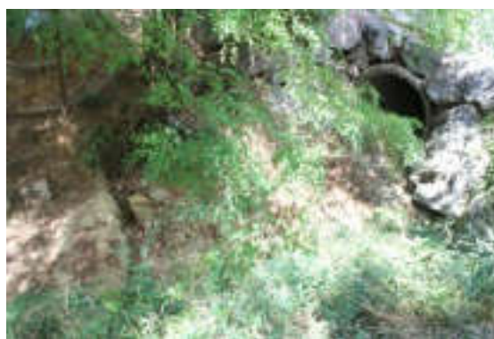
Lit mineur du ruisseau de Lardière et amont de l'ouvrage LAR01
