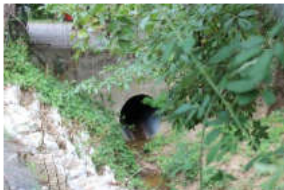
Aval du ruisseau du Saint-Julien - Ouvrage STJ01
