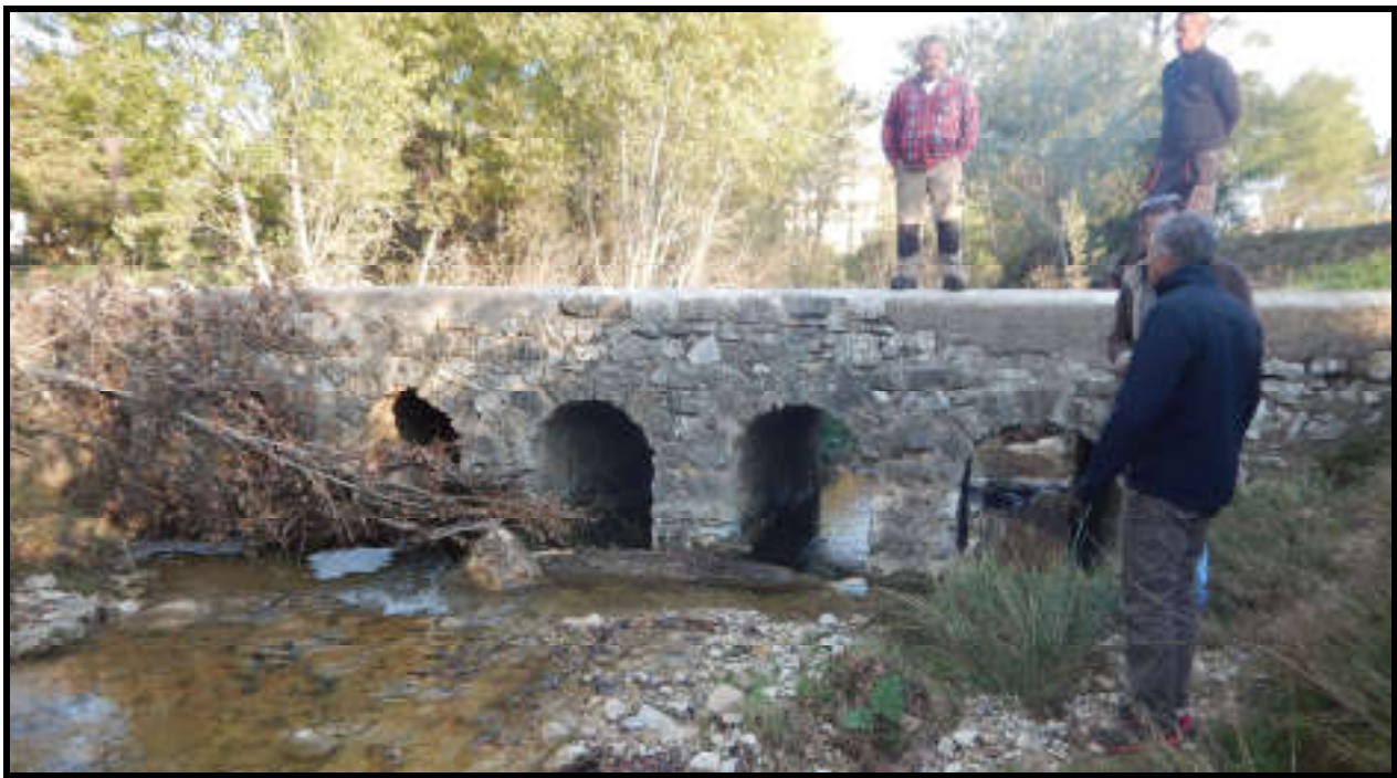
Pont submersible du Rieussec
