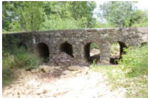
Aval de l'ouvrage RIE03
