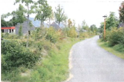
Voie de desserte du lotissement, avec talus planté de part et d'autre formant davantage un chemin rural qu'une rue. Hédé-Bazouges (35). Photo CERTU.
