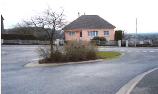
Béton désactivé et aménagement perméable de carrefour. Flers, Route d'Athis
