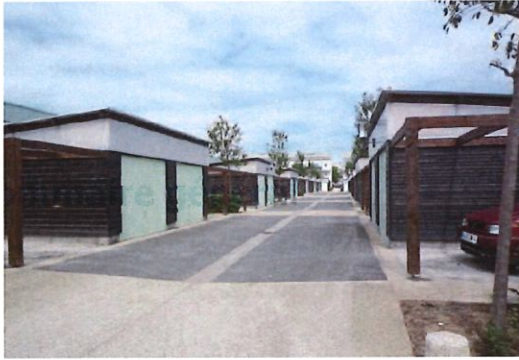
Réduction de la largeur de la chaussée, caniveau central, aménagement de traversées qui ponctuent la rue, ouverture des garages directement sur la chaussée ; Zone 20 (partage de l'espace public) Les Brandons, Blainville-sur-Orne (Photo CAUE 14)
