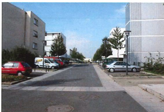
Différenciation des modes de circulation par le choix de matériaux différents, stationnement latéral alterné avec des fosses de plantations et des arbres d'ornement. ZAC Beaugard Saint-Jacques de la Lande, Rennes (35).
