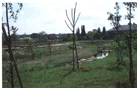
bassin de gestion des eaux pluviales ZAC Beauregard, Rennes
