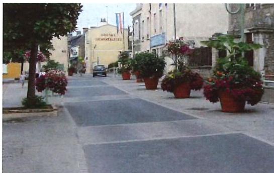
Béton désactivé et pavage forment le trottoir et ses limites. La bande roulante est en bitume.
