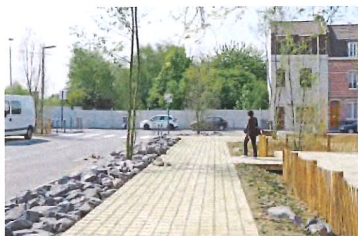
Fossés empierrés pour la récupération des eaux pluviales, servant également à séparer les piétons des voies de circulation.
