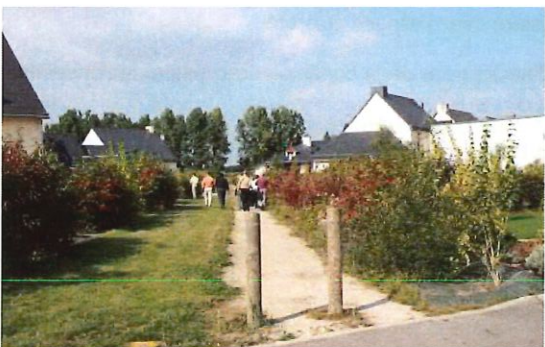
Exemple de cheminement piétonnier en stabilisé, bordure en pierre ou gazon et plantations arbustives, ZAc Beauregard, Rennes
