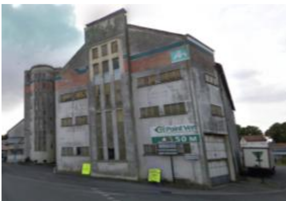
Silo à céréales d'Achiet-le-Grand
