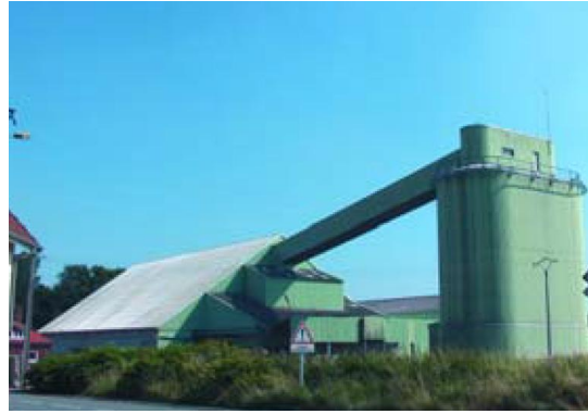
Sucrierie de Bihucourt, sur le sentier des Trois Pourchains
