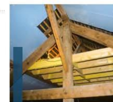
Installation d'un plancher
