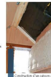
Construction d'un caisson isolé
