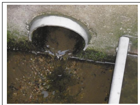
Sortie du deuxième étage
