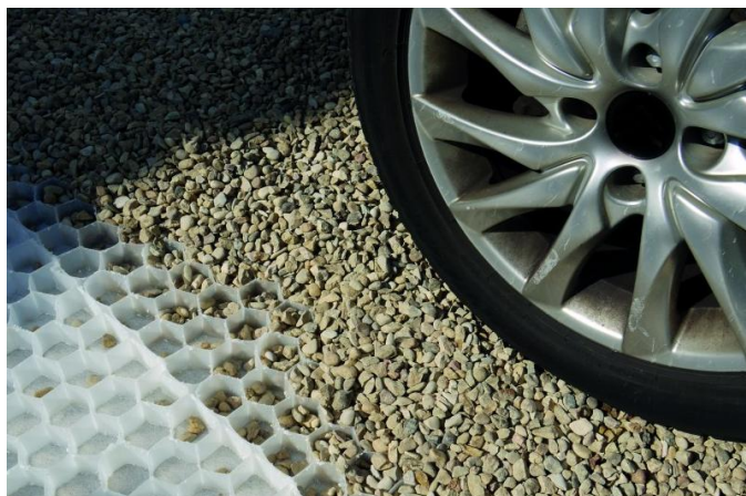
Exemples de revêtements perméables et carrossables
