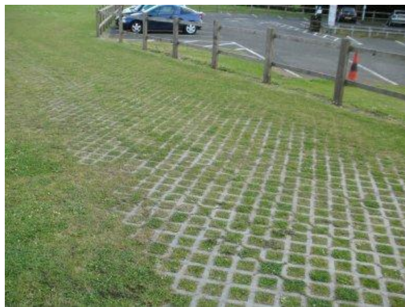
Exemples de revêtements perméables et carrossables
