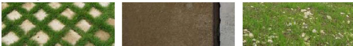
* Exemples de traitements de sols perméables : pavés joint gazon - sols minéraux stabilisés ou compactés - grave enherbée
