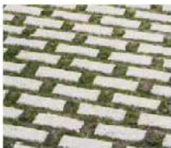
Pavage en béton avec ouvertures de drainage
