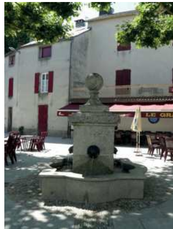
Fontaine rénovée en pierre à Brassac (81) Projet Agence V. Labarthe
