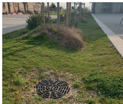
Noue enherbée et évacuation par regard à Saint-Juéry (81)
