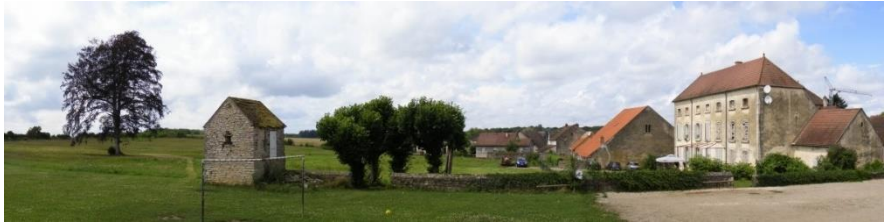
Vue du site
