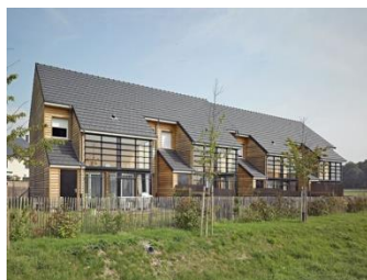
Maisons mitoyennes Petitville (76) Atelier 6.24 architectes
