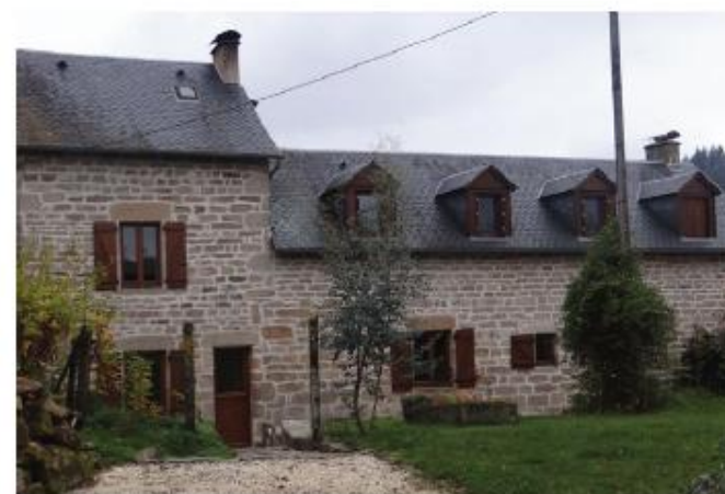
Façade en pierre appareillée apparente avec joints au mortier de chaux ; toiture en ardoise en forme d'ogive ; menuiseries en bois de couleur homogène ; lucarnes jacobine disposées de façon régulière
