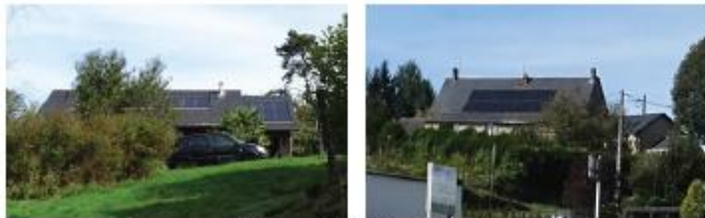
Panneaux solaires plutôt bien intégrés en toiture
