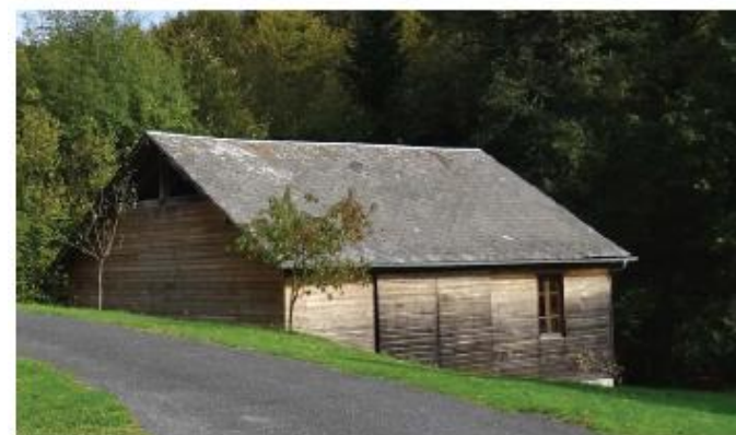
Annexe avec façade en bardage bois de teinte naturelle
