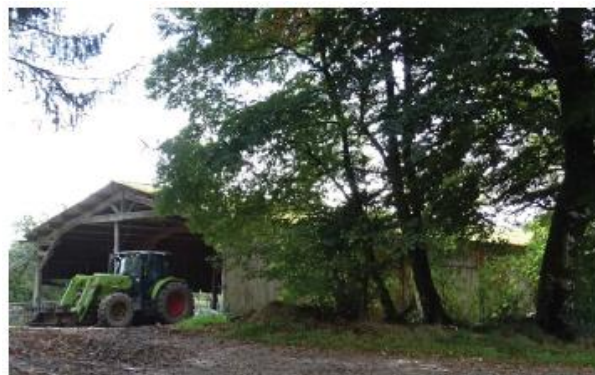
Bâtiment en bardage bois et implantation à l'appui d'une haie arborée
