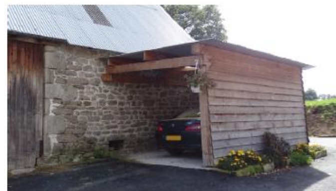
Annexe en bardage bois de teinte naturelle accolé à une construction existante
