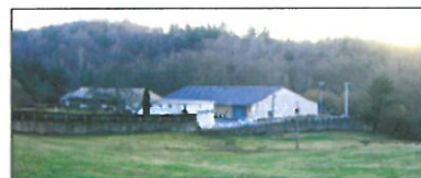
4 Vue des bâtiments de l'usine implantée en important recul de la voirie et délimitée par un mur haut en pierre
