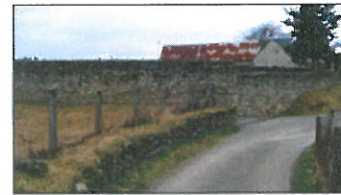
4 De part et d'autre du terrain, les alignements sont marqués par de petits murets en pierre sèche parfois surmontés de clôtures grillagées
