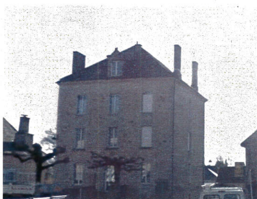
Mairie dans un ancien hôtel particulier, rue Betugum, centre-bourg : plan carré, toiture en 4 eaux, lucarne de façade en pierre.
