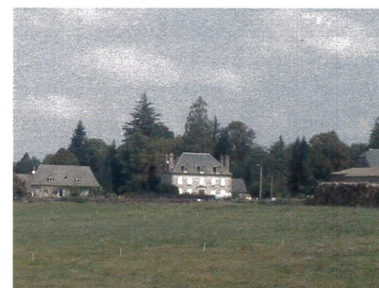
Maison de maître, secteur la Vergne : toiture en pavillon, couverture en ardoise, baies ordonnancées en 5 travées.
