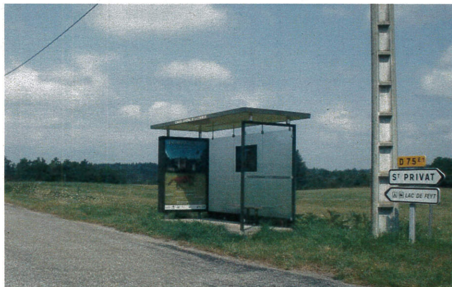
Abribus destiné aux élèves dans un secteur de très faible densité.
