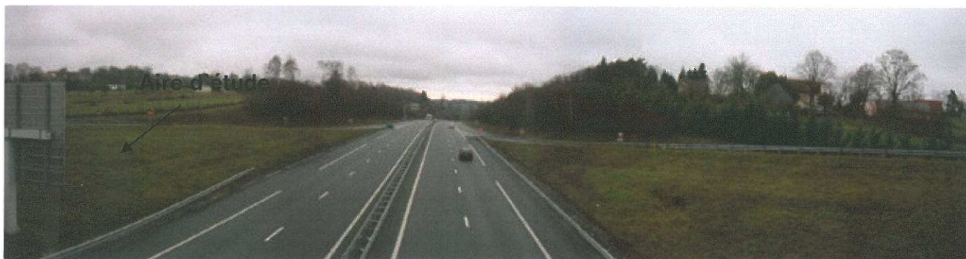
A20, vue en direction de Paris (photo n°2)
