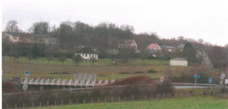
Vue sur le hameau des Quatre-Routes (photos n°12)
