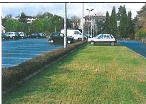
Différence de traitement des espaces de stationnement : enrobé et dalles engazonnées
