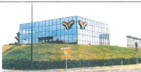
Traitement des limites par des haies vives et un talus engazonné
