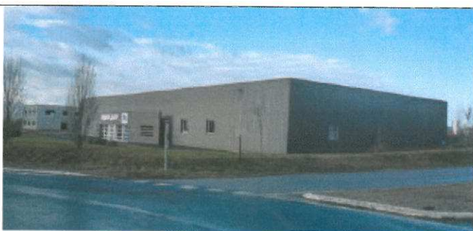
Le bardage anthracite renforce la neutralité de ce bâtiment dans son environnement
