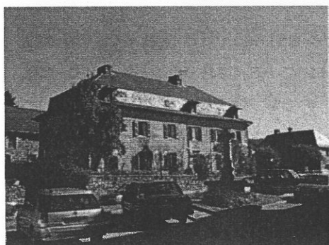
Bâti ancien dans le bourg
