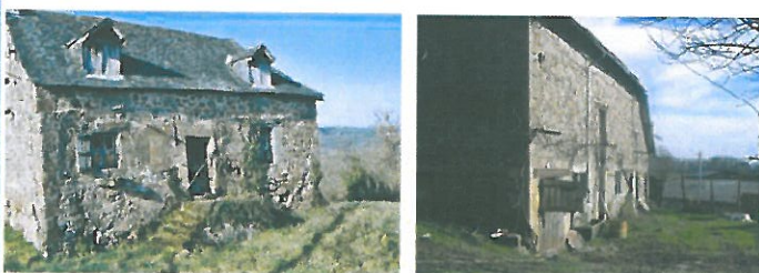
Un patrimoine bâti agricole en état d'abandon
