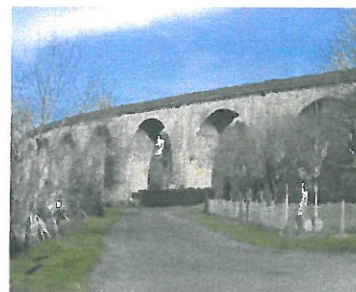
Le viaduc de Vignols
