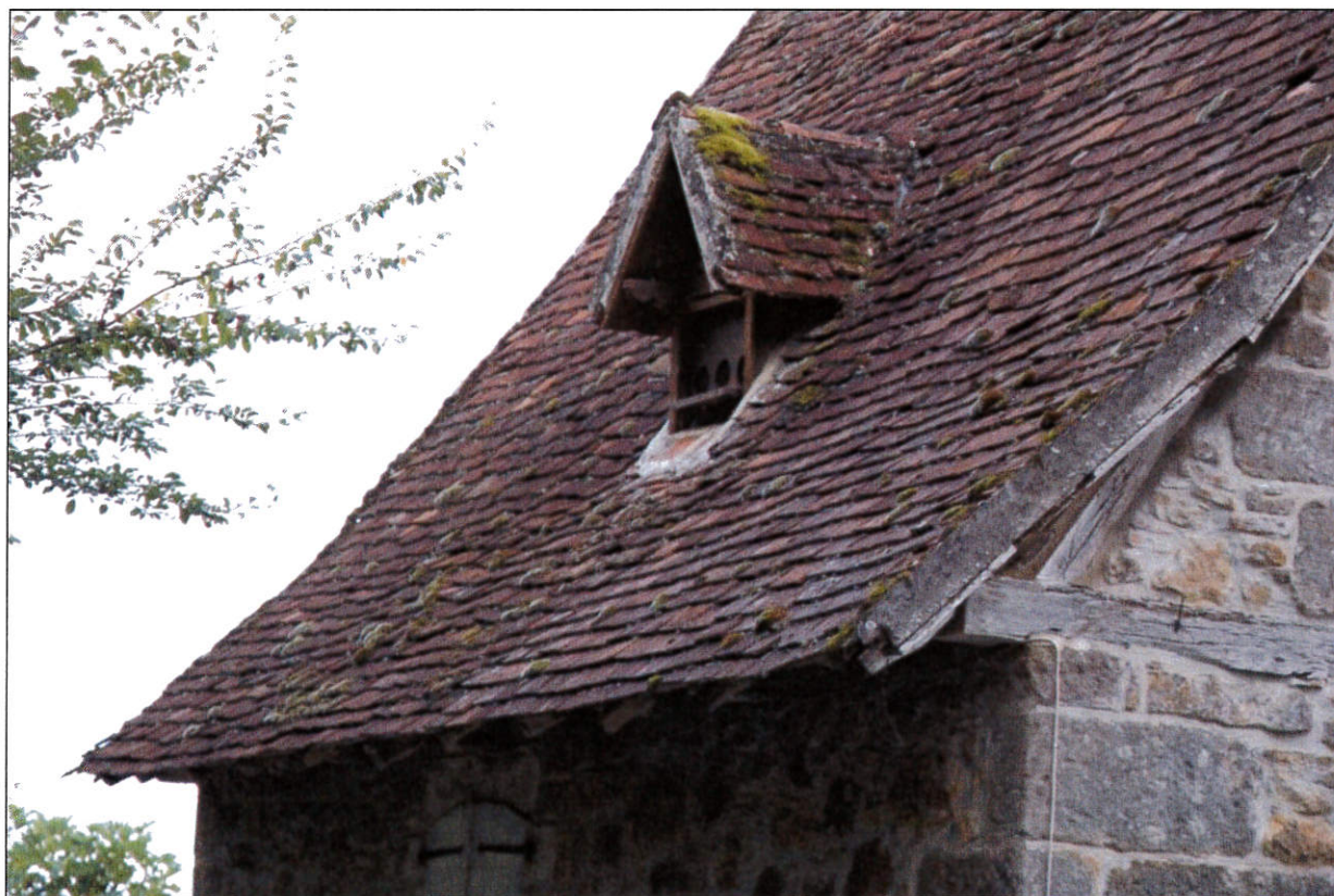
Figure 58 : Lucarne à deux pans aménagée en pigeonnier © ETEN Environnement
