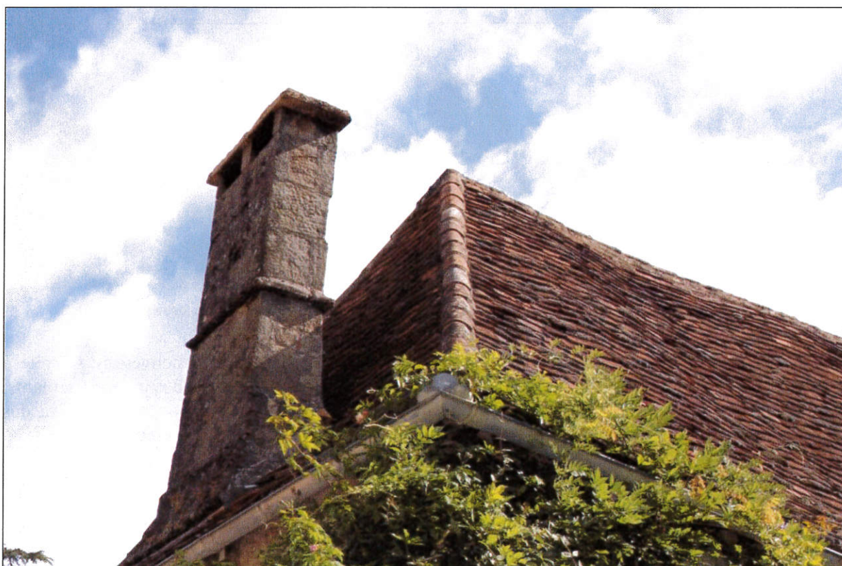
Figure 54 : Faîtage en rang de tuiles © ETEN Environnement
