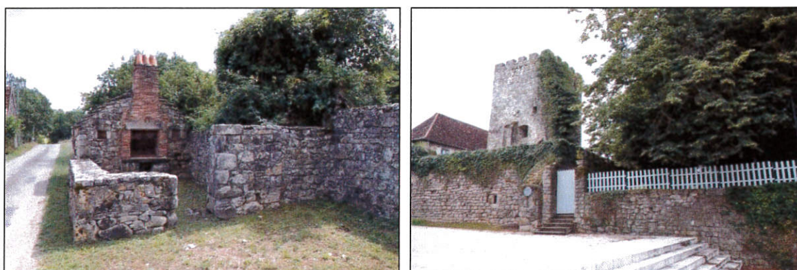
Figure 67 : Des éléments tels que ce four à pain ou la tour peuvent être protégés © ETEN Environnement
