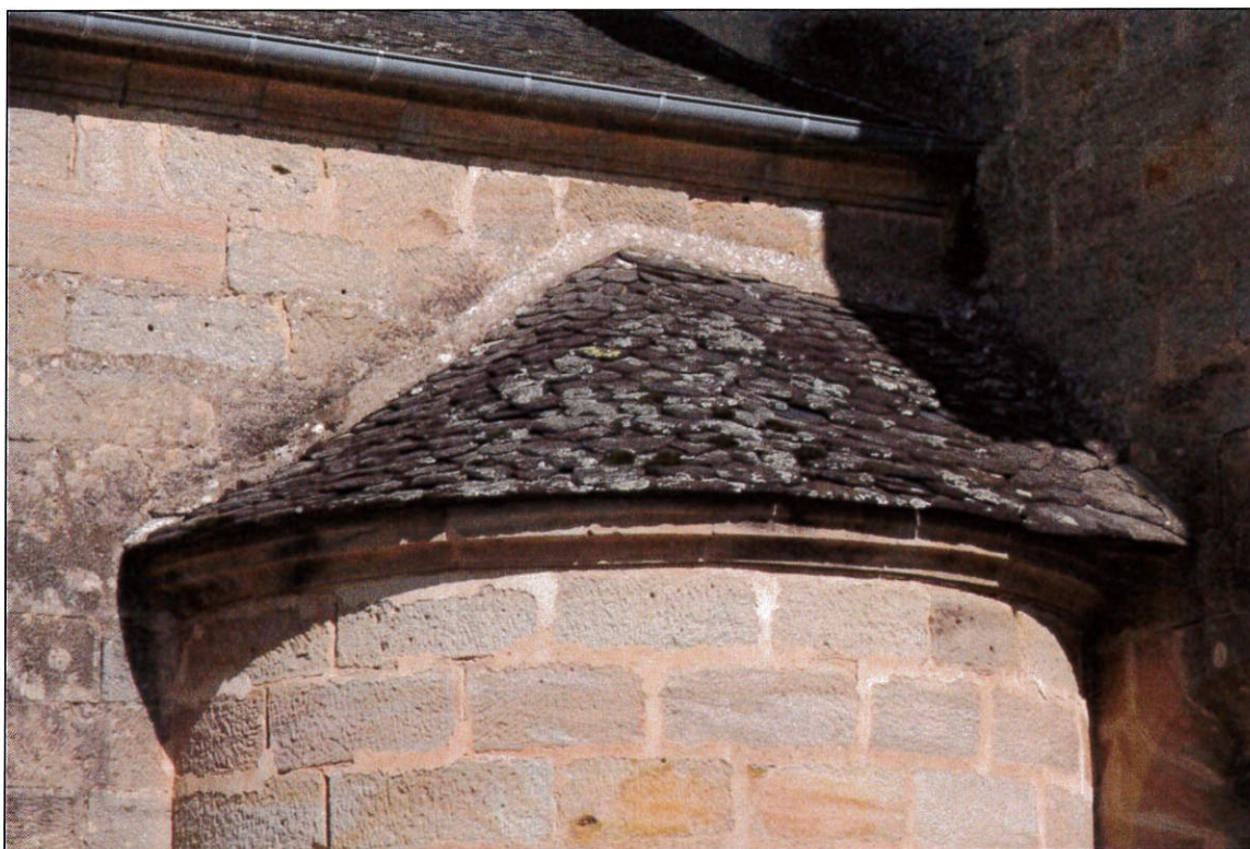
Figure 55 : Lauzes sur l'église de Queyssac-haut © ETEN Environnement
