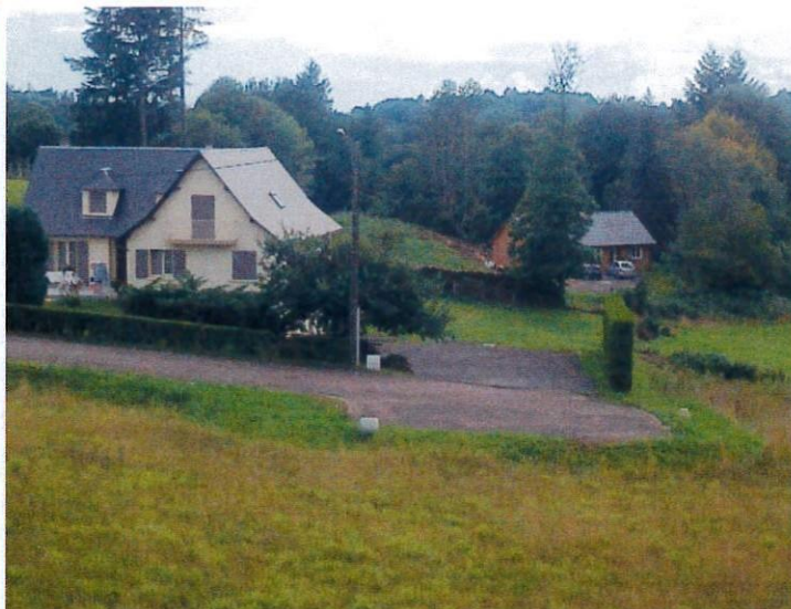
Maisons d'habitation au sud
