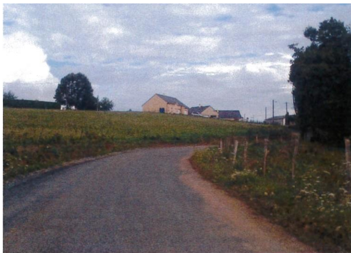
Maisons nouvelles à l'entrée de la rue menant à Faugères
