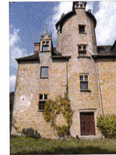
Le château du Peuch, p 55 : les différents niveaux sont desservis par une tour cylindrique engagée.
