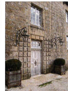
Château de La Rue : la façade est percée de grandes fenêtres sans division organisées en travées
