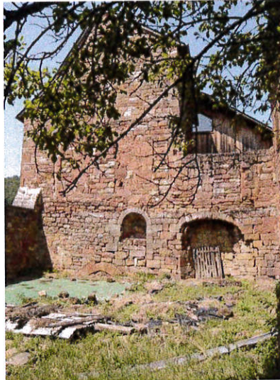
La maison forte de Peyrignac (parcelle n°53)
