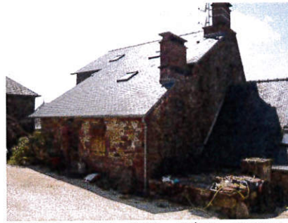
Peyrignac p.53 : cette maison conserve une remarquable cheminée de gré rouge, couronnée d'une dalle de gré portée par des pierres de chant découpées.
