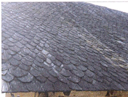
Les Treilles p.175, couverture en écaille d'ardoise.
