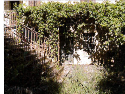
Leygonie p. 60 : détail du garde-corps en ferronnerie protégeant l'escalier.
