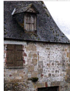
La Martinie p. 182 : cette maison de caractère rural conserve un exemple de lucarne de charpente. Coiffée à deux versants, elle est bâtie en bois.
