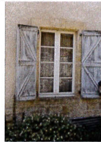
Menuiserie du début du XX e siècle à carreaux moyens accompagnées de contrevents à lames larges assemblées par traverses et écharpes opposées.
