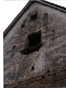
Laroche, p.90 : pignon enduit et badigeonné à la chaux.
