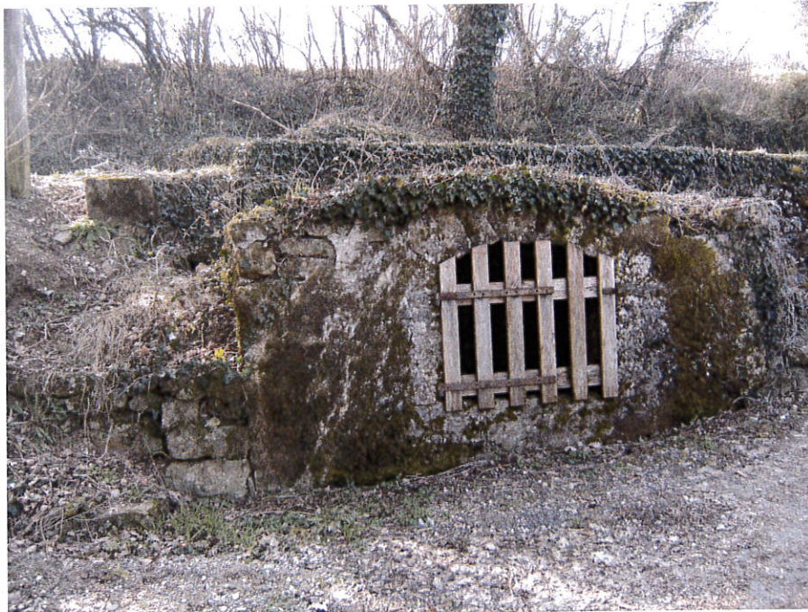
Fontaine et lavoir de Creffond
