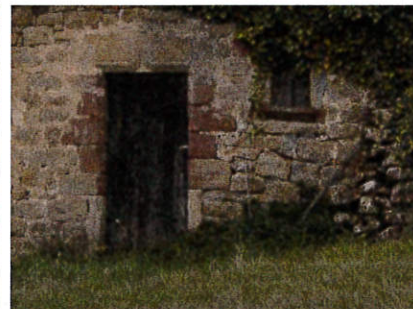
Maison élémentaire à La Borie, p 124 : la porte présente un encadrement rectangulaire surmonté d'un linteau en accolade (plus aplati qu'au XVe siècle et dégagé par un anglet). Elle est accompagnée d'une petite fenêtre chanfreinée)
