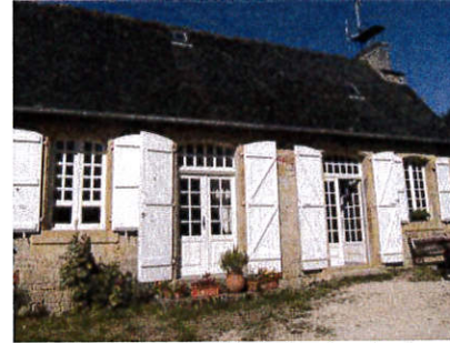
Pommiers, maison p. 211 : la façade présente un appareil irrégulier sans doute destiné à recevoir un enduit comme semble l'attester les encadrements saillants des baies.
