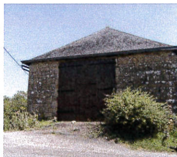
Château de Ligneyrac, p109 Mur de l'ancien rempart en maçonnerie assisée repercée par une porte de grange.
