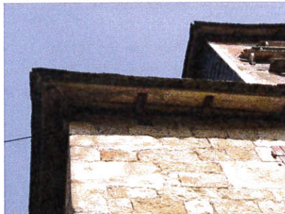
Les Treilles p. 168 a : débord de toit porté par des abouts de chevrons moulurés en bec de flûte. A noter la volige en lame large conservant la trace d'un badigeon ocré.
