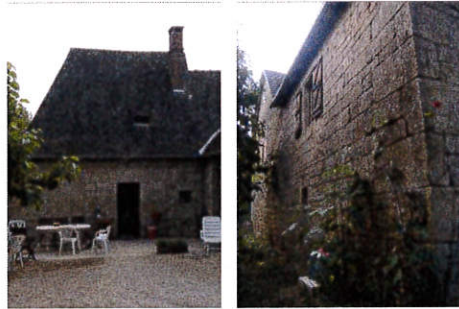
Traversat, maison p. 221 : maison conservant un remarquable appareil destiné à rester apparent
