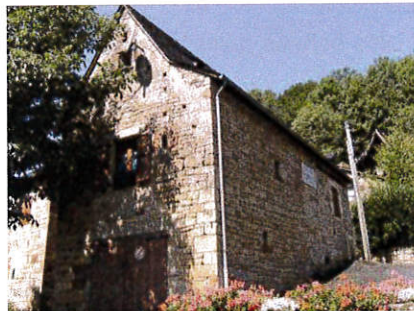
Le bourg, p 130 : maison-bloc présentant un pignon étroit coiffé d'une toiture à deux versants à forte pente (NB : dans cet exemple, la toiture a été remaniée : les coyaux ont été relevés et la couverture refaite en ardoise)
