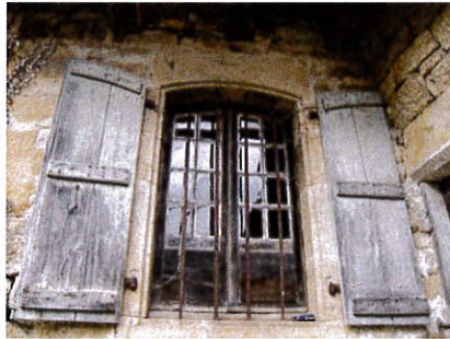
Exemple de menuiserie du XVIII e siècle à petits bois et allège pleine, accompagnée de ses contrevents à lames larges et traverses.
