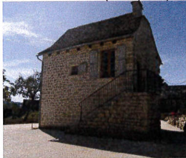
Sabazot, p28 : maison-bloc s'élevant sur deux niveaux : une cave voûtée surmontée d'un étage d'habitation desservi par un escalier extérieur.
