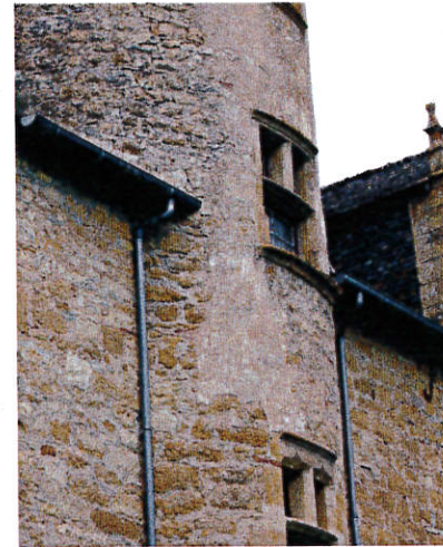
Maison forte du Peuch XV e -XVII e Ses murs en pierres «tout-venant» sont recouverts d'un enduit laissant apparents les encadrements moulurés
