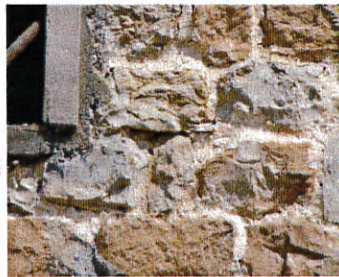
Utilisation du béton et du ciment,
