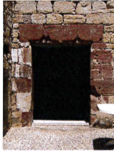
Château de Ligneyrac, p 235 : porte surmontée d'un linteau à double accolade sans doute en remploi.
