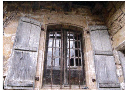
Laroche p. 90 : fenêtre conservant une menuiserie à petits bois, à allège pleine. Les contrevents sont à lames larges maintenues par des traverses cloutées.
