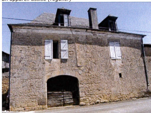
Sabazot p. 296 (datée 1837) : cette façade conserve un bandeau sous toiture lissé et souligné d'un badigeon blanc à la chaux
