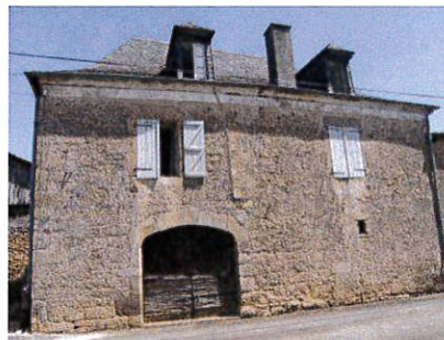
Sabazot p. 296 (datée 1837) : cette façade conserve un bandeau sous toiture lissée et soulignée d'un badigeon blanc à la chaux
