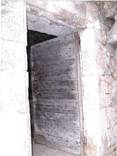
Maison parcelle n°168 c (détail de la porte précédé d'un bolet)
