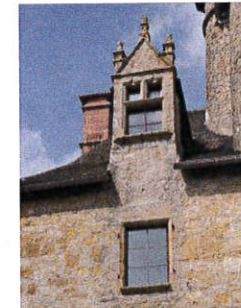
Château du Peuch : exemple de lucarne à fronton
