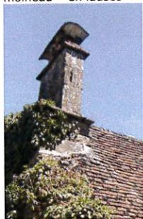
Lafont p.112 : souche de cheminée en maçonnerie appareillée à Redans
