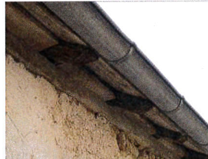
Le Bourg, p. 137 : débord de toit porté par des abouts de chevrons moulurés. A noter la volige à lames larges qui habille la sous-face du débord de toit.
