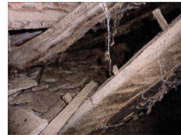
Maison à Sabazot (Ligneyrac) : à noter la présence des chevilles de bois fichées dans les chevrons et destinées peut-être à la fixation des gerbes de paille.
