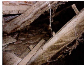
Maison à Sabazot (Ligneyrac) : à noter la présence des chevilles de bois fichées dans les chevrons et destinées peut-être à la fixation des gerbes de paille.
