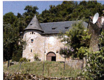
Le Bourg, p124 : autre demeure dont les différents niveaux sont également desservis par une tour cylindrique, semi hors-œuvre.
