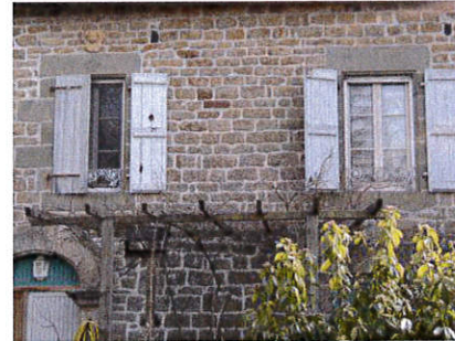
Traversat p. 273 : rare exemple de fenêtres équipées de garde-corps (ici, il s'agit de remarquables garde-corps en fonte moulée).
