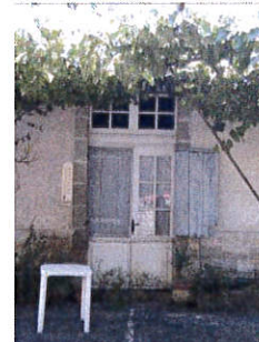
Le Bourg p. 90 : menuiserie de porte vitrée à panneaux compris imposte vitrée, et demi contrevents.
