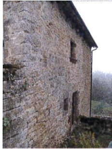
Creffond p41 : porte d'entrée chanfreinée flanquée d'un petit jour rectangulaire.
