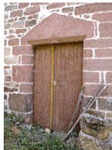
Peyrignac, 51 : porte de cave surmontée d'un linteau monolithique en gré orné d'un arc en accolade
