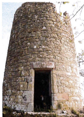
AVAP de Ligneyrac - Diagnostic Le moulin banal des Robert, au Vignal du Château. Seconde moitié du XVe siècle - début XVIe siècle.
