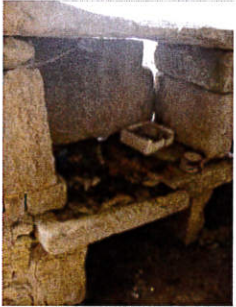
Leygonie p.65 : évier aménagé dans le mur d'échiffre de l'escalier extérieur.
