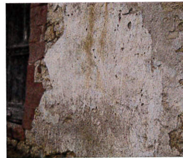
Les Treilles, p.168 c : vestige d'un enduit fin à la chaux recouvert d'un badigeon blanc.
