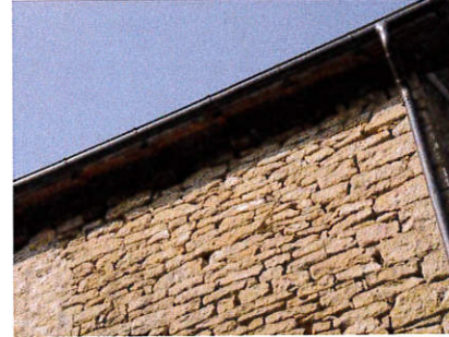
Creffond p41 : débord de toit sectionné au nu de la façade
