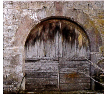
Exemple remarquable de porte de cave
