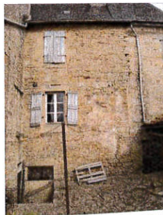
La Borie, p.119 : vestiges d'un enduit lissé fin probablement badigeonné.
