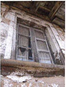
Leygonie P65 : croisée surmontée d'un linteau à double accolade, probablement dotée, à l'origine, d'une traverse et d'un meneau dont elle conserve la trace.
