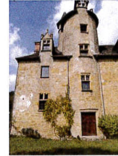
Le château du Peuch, p 55 : les différents niveaux sont desservis par une tour cylindrique engagée.
