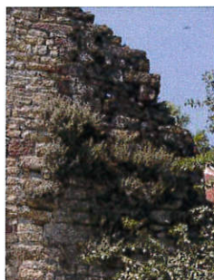
Château de Ligneyrac, p235 Arrachements signalant la présence d'une aile fermant la cour à l'Est
