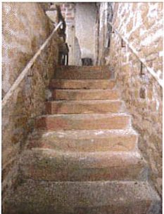
Leygonie p.65 : escalier en pierre desservant l'étage d'habitation
