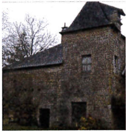
Les Treilles. Escalier rampe sur rampe dans une tour.
