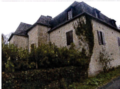
Liat p. 228 : maison relevant de plusieurs campagnes de travaux, couverte d'un toit à combles brisés.
