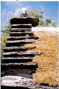
Exemple de couverture en chaume arrêtée en rives par un pignon en lauses (photo ass. Cézallié).
