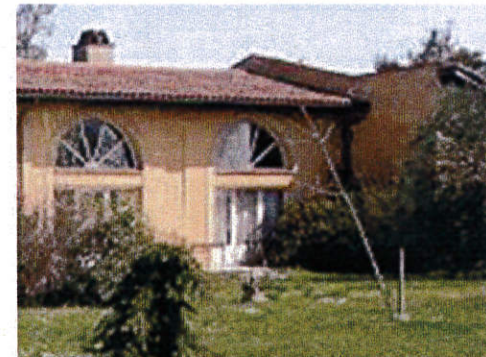
- Non : Ferme lauragaise: les châssis blanc recouper les grandes ouvertures des hangars de façon inesthétique.
