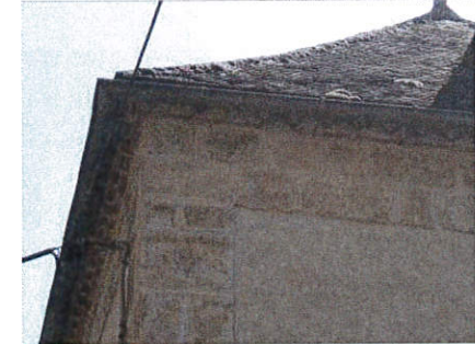
Le Bourg, ancienne école, p. 90 : la toiture est soulignée d'une génoise simple.
