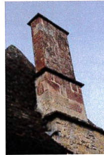
Laroche p90 : remarquable souche de cheminée à redans
