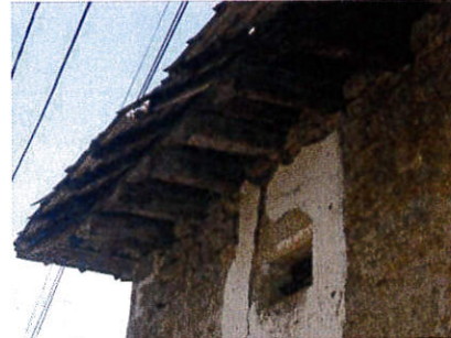
Leygonie p 82 : vestiges d'enduit fin badigeonné.
