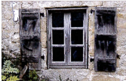
Exemple de menuiserie du XIX e siècle à carreaux moyens et contrevents à lames larges et traverses.
