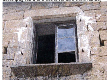
Laroche, maison p.90 : baie à encadrement chanfreiné et appui saillant mouluré.
