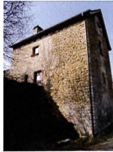
Creffond, p 41 : ici la maison insérée dans le relief s'élève sur quatre niveaux : deux niveaux de caves surmontés d'un niveau d'habitation et d'un comble
