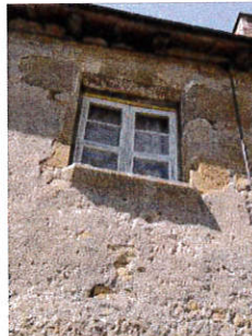
Le bourg, p.246 : la façade conserve les vestiges d'un enduit à la chaux venant mourir sur le chanfrein de la baie. Le chanfrein conserve des traces de badigeon blanc.
