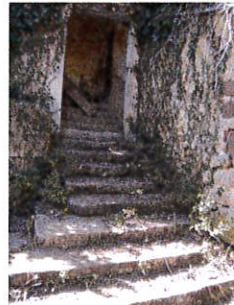
Sabazot p.43 : pierre d'écoulement attestant de la présence d'un évier sur le bolet
