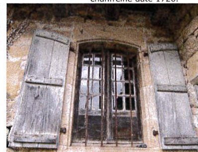
Laroche p. 90 : fenêtre conservant une menuiserie à petits bois, à allège pleine. Les contrevents sont à lames larges maintenues par des traverses cloutées.
