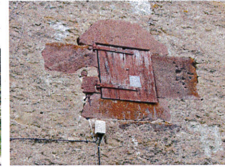
Enduit au Peuch
