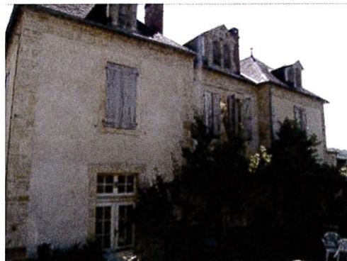
Le bourg p. 90 (école). La façade de l'ancienne école est destinée à recevoir un enduit encadré par une modénature saillante : bandeaux, chaînes d'angles, encadrements de baies..
