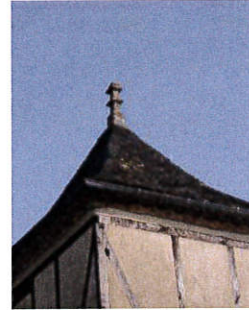
Traversat p. 273 : exemple d'épis de faitage en pierre.
