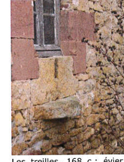
Les treilles, 168 c : évier ménagé sous une fenêtre.
