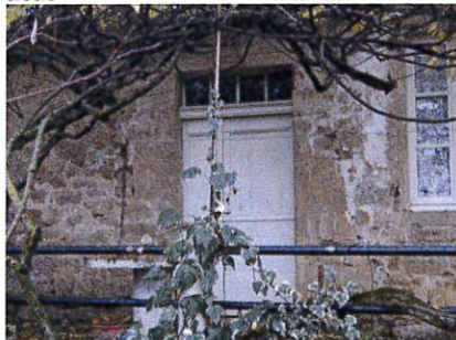
Vinhals des Plats, p. 155 : porte d'entrée pleine à cadre tiercée surmontée d'une imposte vitrée
