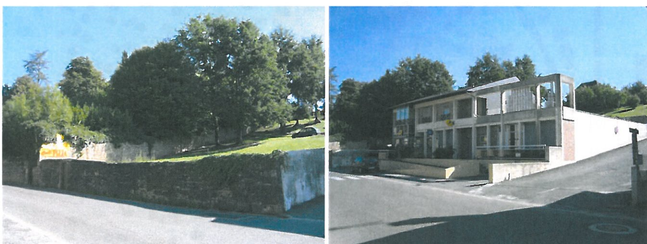
Vue de la partie NORD OUEST de la zone depuis la Route du Docteur Soufron, à proximité de la Poste
