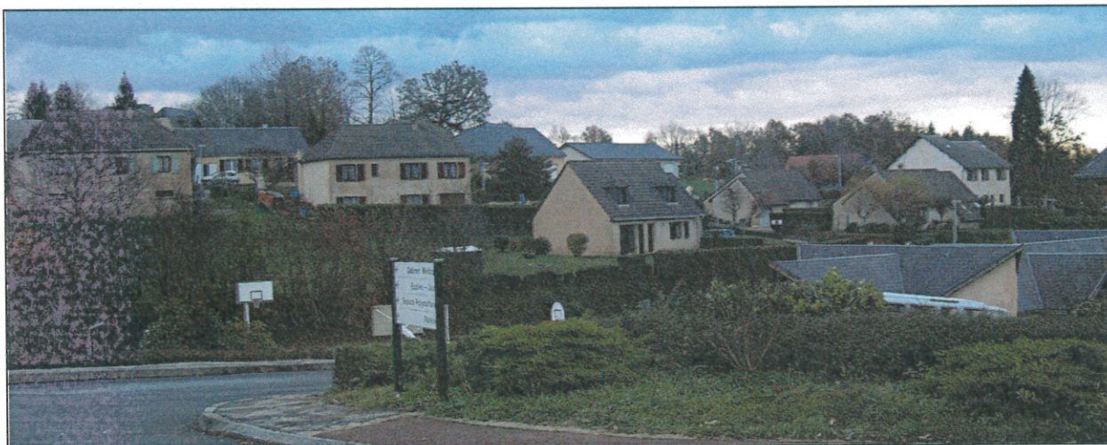
Figure 49: Zone d'extension récente du bourg.
