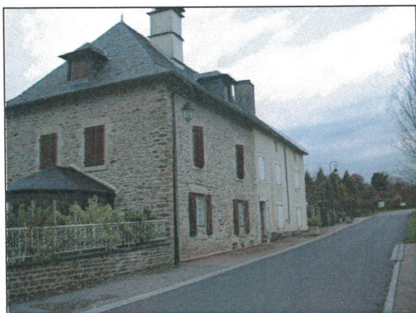
Figure 39 : Maison de pierre récente.
