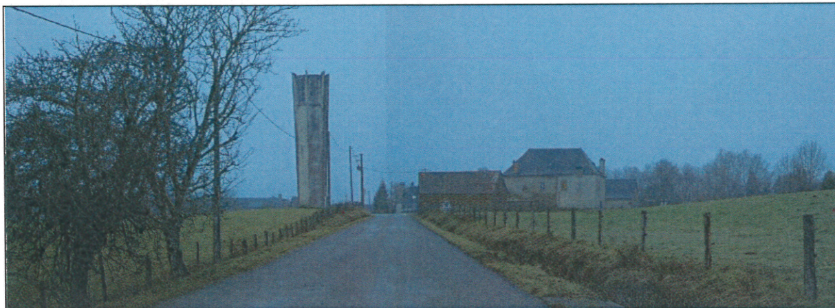
Figure 45: Le réservoir d'eau désaffecté : symbole de l'entrée du bourg étendu.
