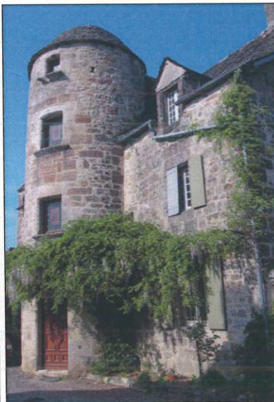
Lucarne en pierre à fronton droit en façade interrompant l'avant-toit
