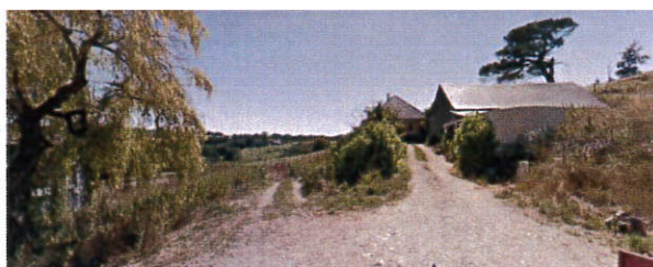
Construction issue de corps de ferme en zone A
