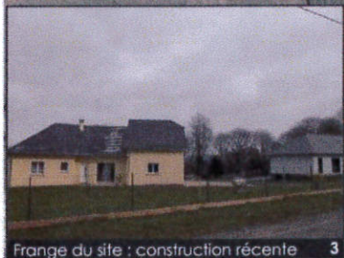
Frange du site : construction récente
