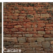
Calcaire Appareillage en terre Charrier-Ferrière
