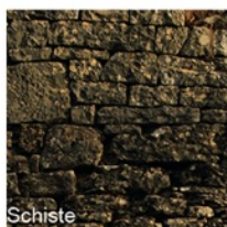
Schiste Appareillage en terre Charrier-Ferrière
