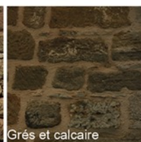
Grès et calcaire Appareillage en terre Lissac-sur-Couze
