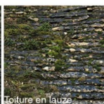
Toiture en lauze Charrier-Ferrière
