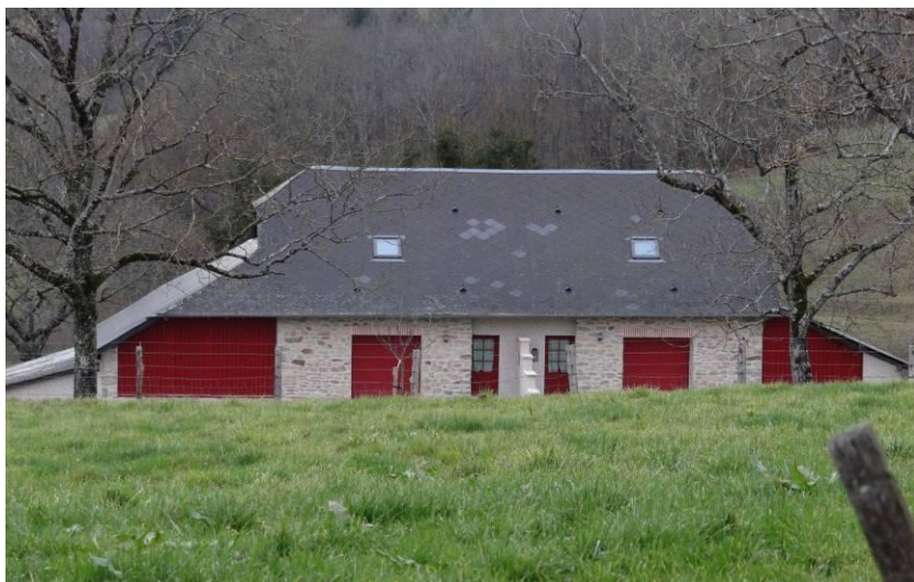
Exemple de logements intermédiaires sur la commune.
