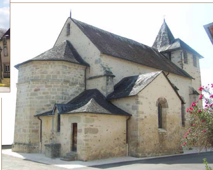
Chameyrat - Façade Nord de l'église
