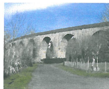
Le viaduc de Vignols
