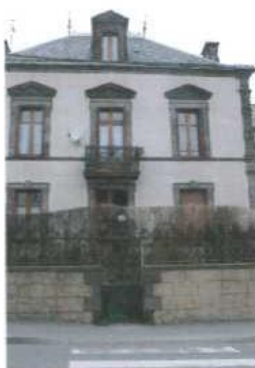
Enduit fin bien réalisé
