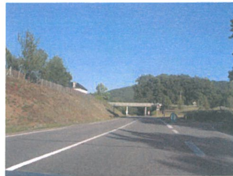
Talus, plantations et bâti existant entre la RN et la zone AU1 (à gauche)
