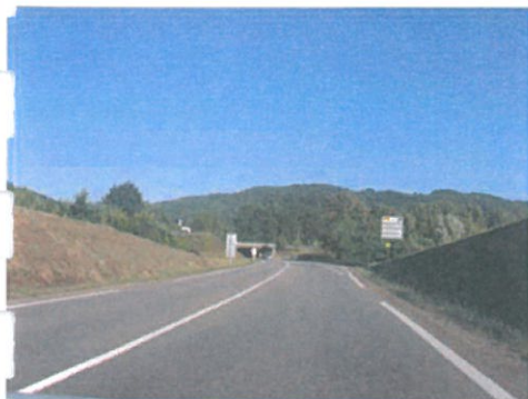
Talus et végétation au droit de la zone Au1 (à gauche)
