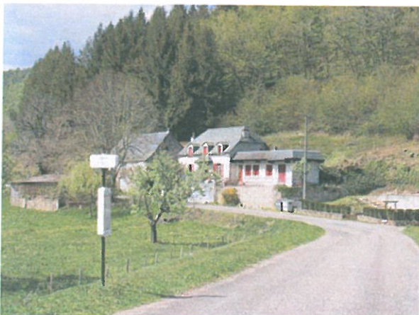
Le pont de la Chapelle
