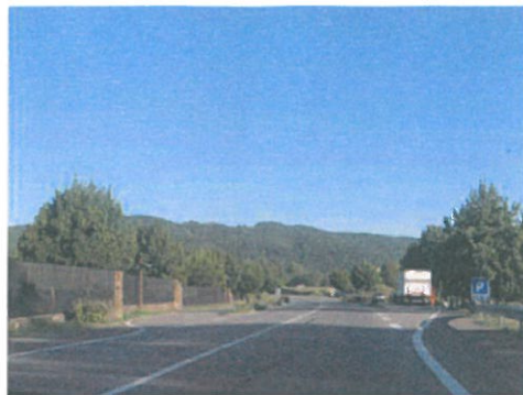
Mur anti-bruit et arbres au droit de la zone U (à gauche)
