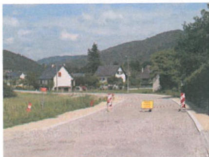
Lotissements en construction dans le secteur du Pilou
