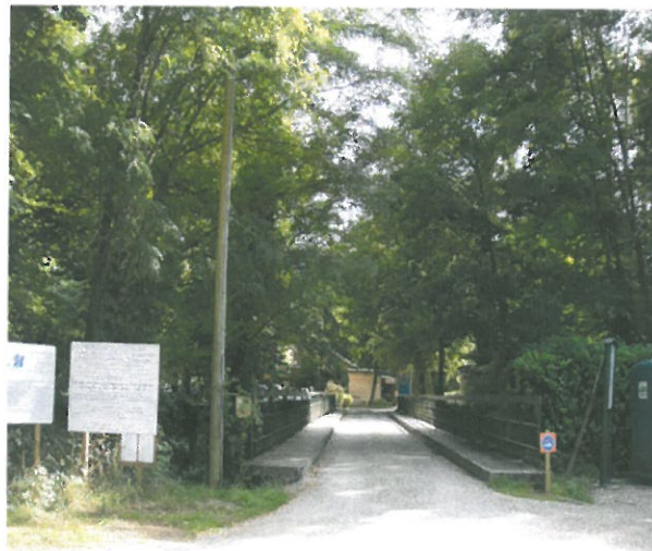
. passerelle mixte : accès principal au centre touristique, enjambant le canal des Gabariers
