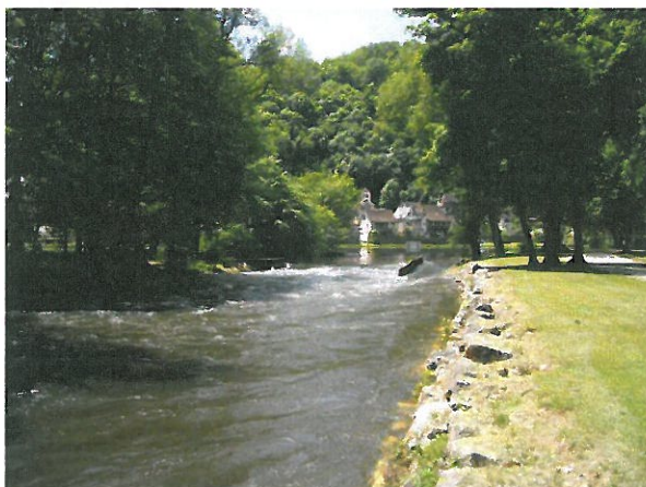
Photographie 1 : Canal des Gabariers, à l'amont
