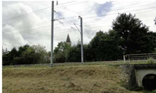
Voie ferrée surélevée par rapport au Craon, rivière traversant le bourg. Nous apercevons le clocher derrière la haie bordant la voie ferrée.
