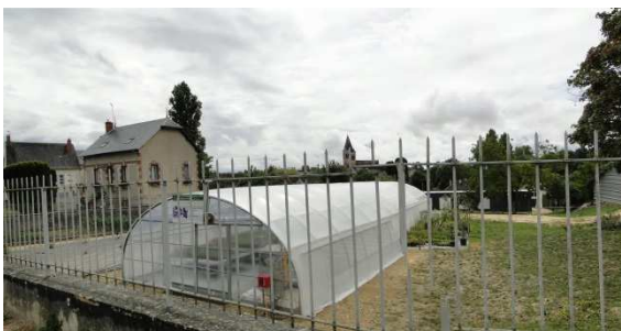
Vue sur une des parcelles du lycée d’enseignement professionnelle privé agricole situé le long de la RD976. Le bâtiment principal du lycée est situé à quelques mètres de là en plein cœur du bourg.
