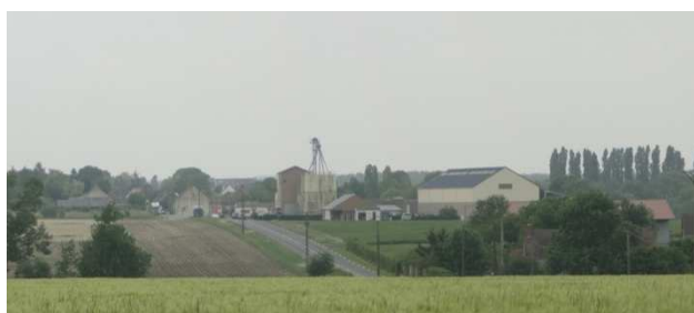
RD 976 : Entrée Ouest Hameau « Battereau » à droite au premier plan dans son enveloppe végétale, puis les champs cultivés et la zone d'activités de Battereau avec silos et différentes entreprises au second plan. L'habitat au troisième plan avec les boisements au fond. Clocher de l'Eglise au bout d'un alignement de peupliers à droite.
