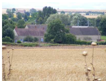
Habitat en ferme côté entrée Ouest du bourg
