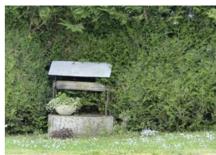
Puits dans le centre bourg
