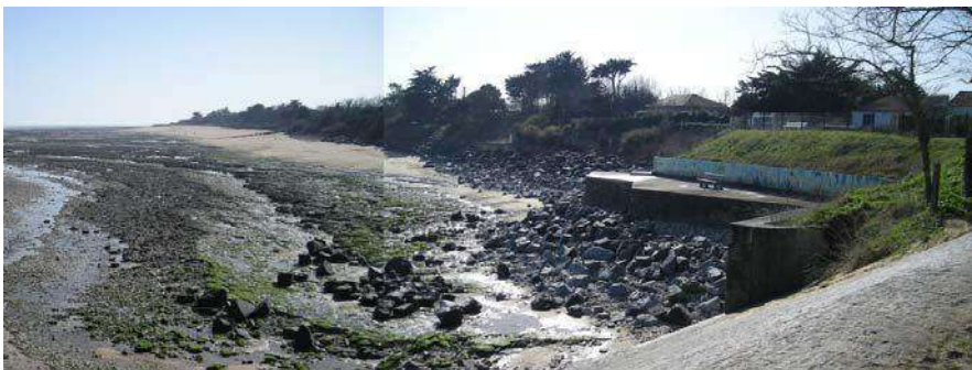
Vue depuis la digue vers le sud-est : l'érosion de la dune créé des falaises ; l'urbanisation est masquée par le relief et la végétation dunaires
