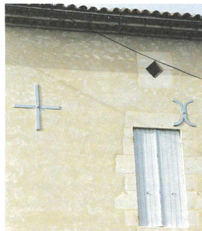
Enduit de chaux aérienne et de sable sur moellons, venant se raccorder exactement au niveau des pierres de taille
