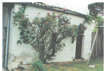
Un rosier habille cette façade très simple.
