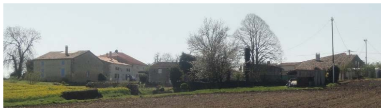
Vue sur le hameau groupé de La Vacherie situé sur un point haut
