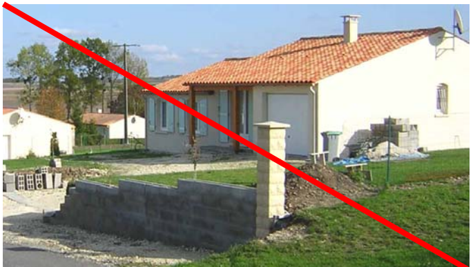
Mur en décrochement et pilier
