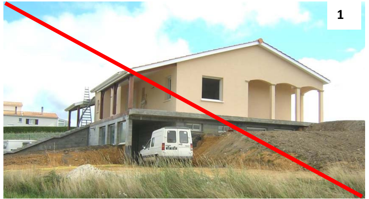
1 Implantation sur plateforme sur-élevée, importants mouvements de terrains
