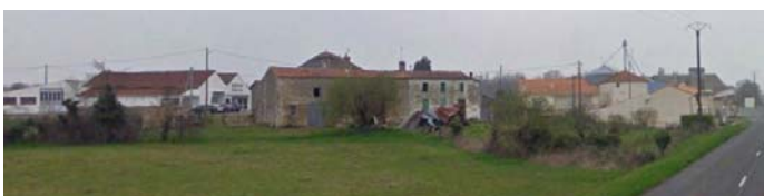
Vue sur la partie Nord aux abords des établissements Isidore
