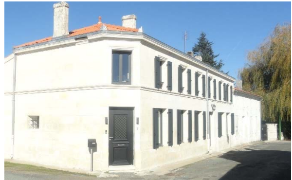
Maison de bourg avec façade d'angle en pierre de taille de modénatures en façades, encadrements moulurés (en face de l'église)
