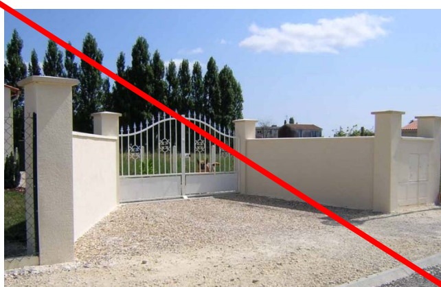
Piliers de portail en maçonneries imposantes sans lien avec la clôture (grillage).
