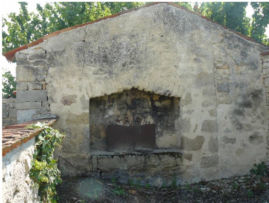
Four à pain privé - Impasse du vieux fours
