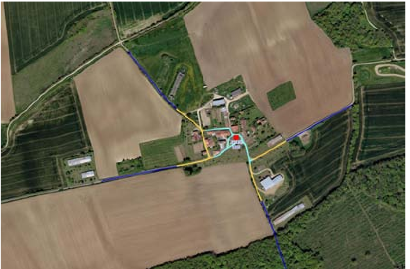
Point d'Eau Incendie - Echarbot
