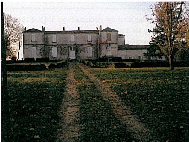
maison de maître à Souillac
