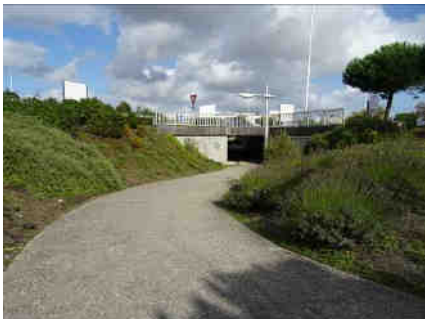
Liaison douce passant sous la RD25
