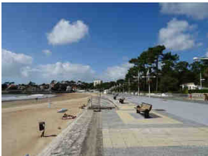
Plage de Nauzan et sa promenade bordées par l'urbanisation sous les arbres
