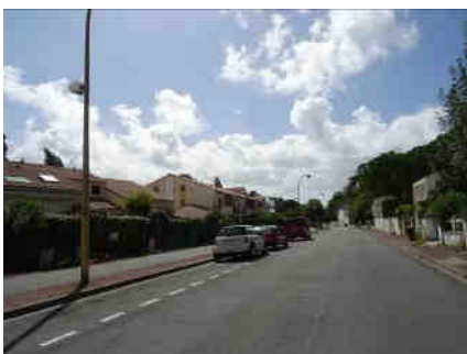
Avenue de Nauzan Plage offrant de larges espaces de stationnement
