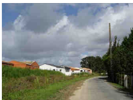
Frange bâtie en évolution le long de la ZAC du Cormier aux Battières en cours de construction - Chemin de la Source
