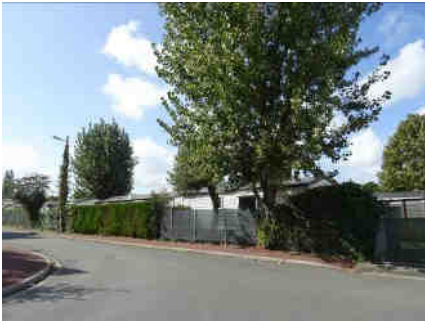
Clôture faite de matériaux hétérogènes donnant un aspect assez dégradé : grillage doublé d'une toile, haie de thuya, portail avec grillage...
