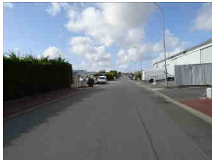
Absence d'aménagement cohérent et d'insertion paysagère du bâti - Rue Georges Claude
