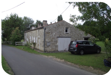
Des toitures en double-pente asymétrique...
