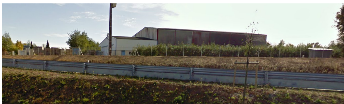
Vue sur la stabulation depuis la RCEA
