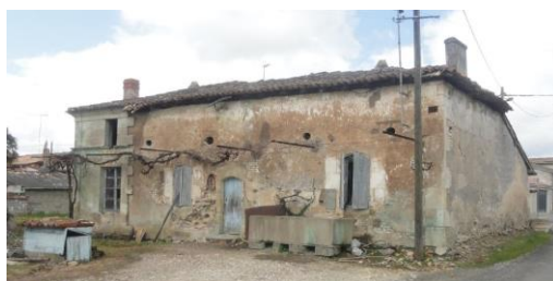
6. Ensemble bâti vacant Rue des Tilleuls
