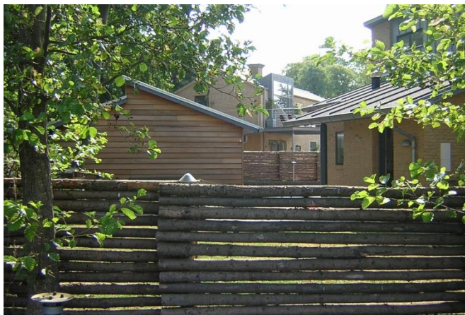
Barrières en bois naturel en limites séparatives
