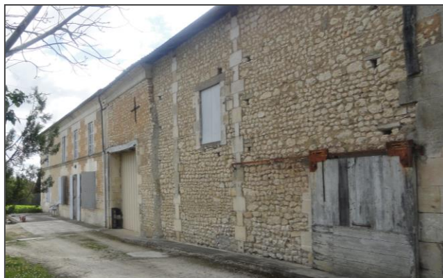
Longère prolongée d'une vaste dépendance agricole aux moellons apparents.
