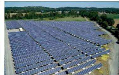
Parc Solaire avec Trackers – 4.5 MWc Lavernose (31) Foncier Communal → Développement, Financement, Construction et Exploitation → Ancienne gravière remblayée / Site BASIAS
