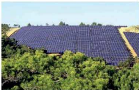
Parc Solaire – 3.8 MWc Commune de La Tour sur Orb (34) Foncier Communal → Développement, Financement, Construction et Exploitation → Ancienne mine de bauxite
