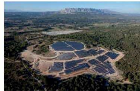
Parc Solaire – 4.5 MWc Fuveau (13) Foncier Privé → Développement, Financement, Construction et Exploitation → Ancien terril de mine / Site ICPE
