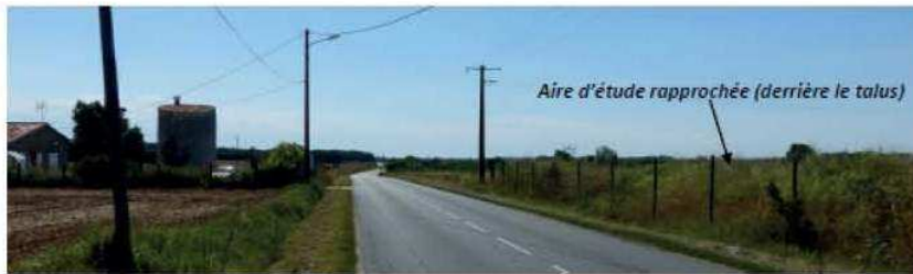
13-Vue depuis la D238 : le Moulin des Brandes isolé de la route par un mur et un talus limite les vues sur l'AER
