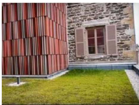
Toiture végétalisée (source : Grand Lyon)
