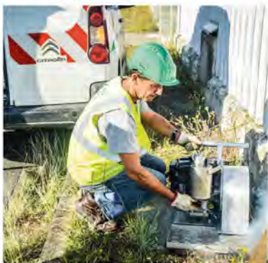
Test "à la fumée" pour la vérification des réseaux.
